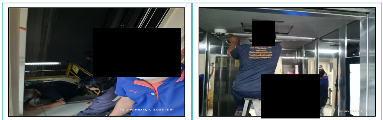
รูปภาพที่ 1.45 รูปภาพช่างลิฟต์ดำเนินการตรวจสอบลิฟต์และตั้งเวลาปิดประตูลิฟต์
