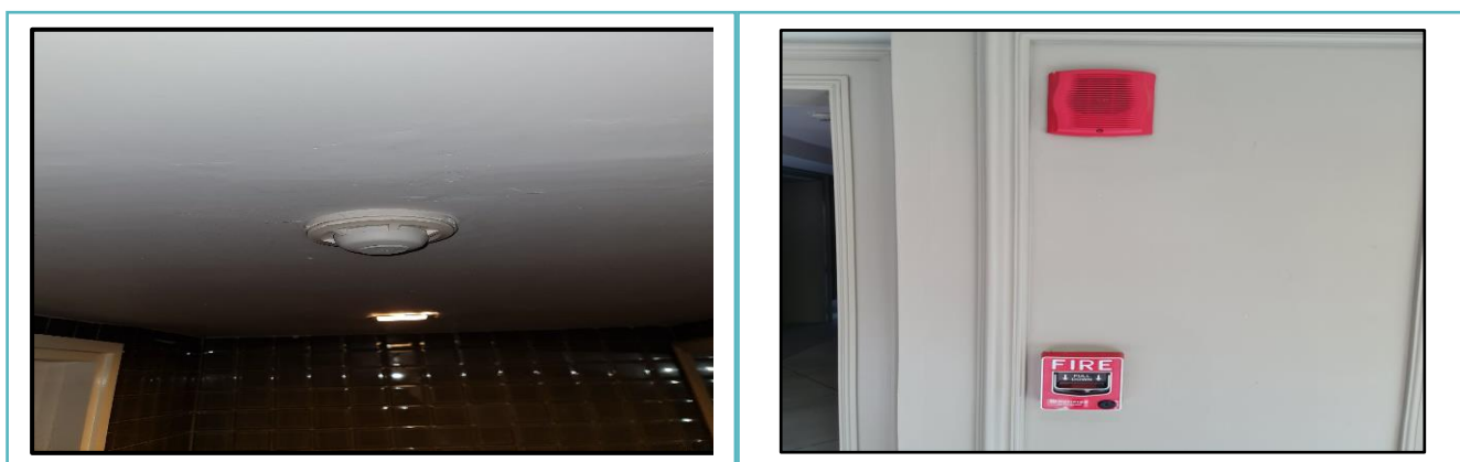
รูปภาพที่ 1.52 อุปกรณ์ระบบสัญญาณเตือนภัย อุปกรณ์ตรวจจับความร้อน (Heat Detector) และ อุปกรณ์แจ้งเหตุเพลิงไหม้แบบเสียง (Fire Alarm Speaker)
