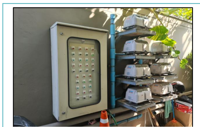
รูปภาพที่ 1.63 ระบบ Aerator ที่ติดตั้งทดแทนระบบบำบัดขนาด 0.59 ลูกบาศก์เมตร จำนวน 1 ชุด (3 ใบ)
