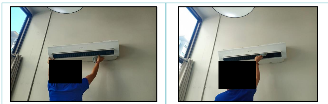
รูปภาพที่ 1.31 รูปภาพช่างล้างเครื่องปรับอากาศ
